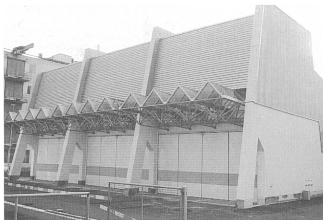
Beim neuen Unterwerk Schweizerhalle war zwar wie bei allen Anlagen dieses Typs die Funktionalität oberstes Gebot, mit der Verwendung postmoderner Architekturelemente konnte aber eine Lösung gefunden werden, die auch architektonisch überzeugt
