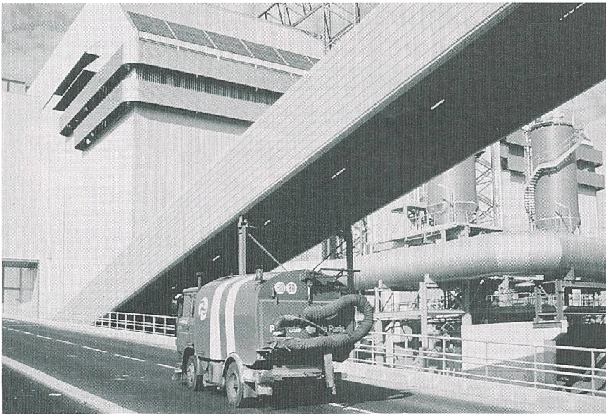
Bild 2 Hausmüllverbrennungsanlage in Saint-Ouen im Norden von Paris (Foto: D. Taulin Hommel/ADEME)
