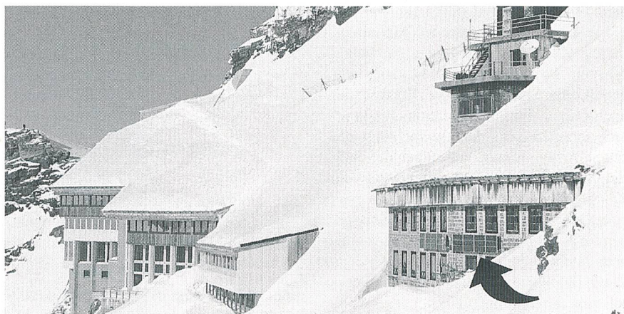
Bild 1 Flugaufnahme der höchstgelegenen netzgekoppelten Photovoltaikanlage der Welt, die seit Oktober 1993 an der Fassade der hochalpinen Forschungsstation Jungfraujoch in Betrieb steht. Links im Bild erkennt man das Restaurant Jungfraujoch (Foto Siemens)
