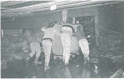
Unter sehr erschwerten Bedingungen wird ein Transformator zur Station transportiert
