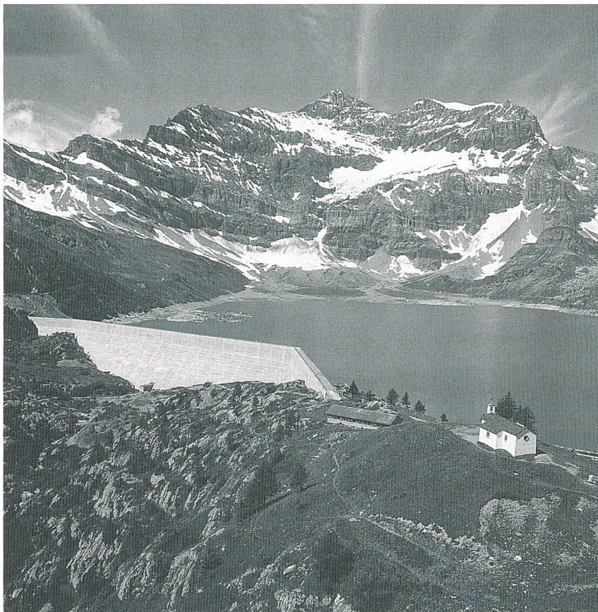
Figure 3 Barrage de Salanfe (VS), avec chapelle (photo H. Preisig)
