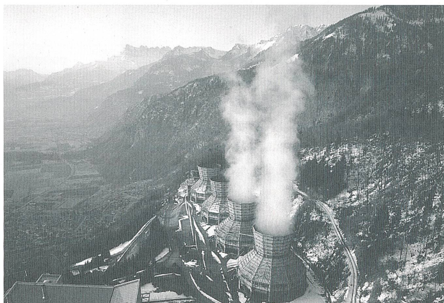
Figure 5 Centrale thermique fossile de Chavalon/Vouvry (VS), tours de refroidissement (photo M. Schobinger)
