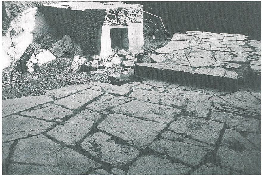
Bild 10 Restaurierte Überreste, Blick auf das rechte Widerlager (1983)
