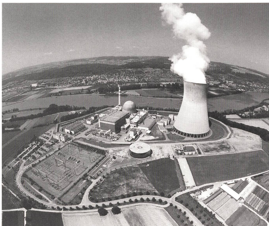
Flugaufnahme des Kernkraftwerks Leibstadt, im Hintergrund der Rhein mit Dogern (links) und Waldshut (rechts) auf der deutschen Seite.
