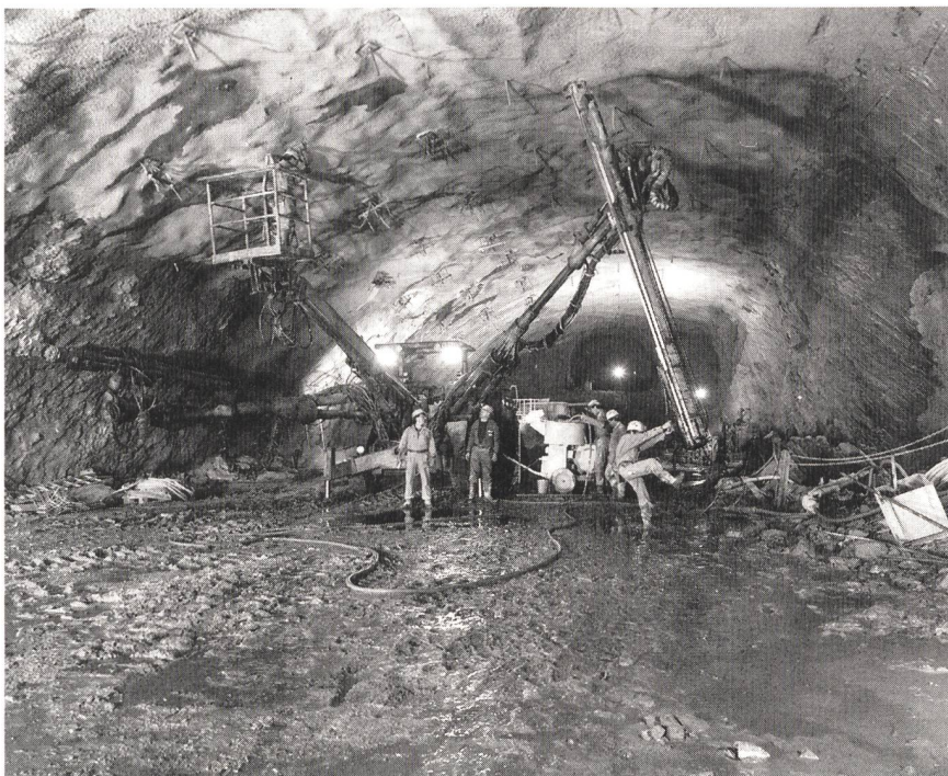
Das Gewölbe der Kaverne von Bieudron.
