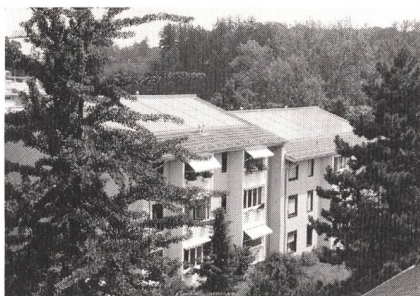
Bild 12 Solare Vorwärmung in einem Mehrfamilienhaus in Biel: Kosten-Nutzen-Verhältnis besser als erwartet (Foto: Krebs AG).
