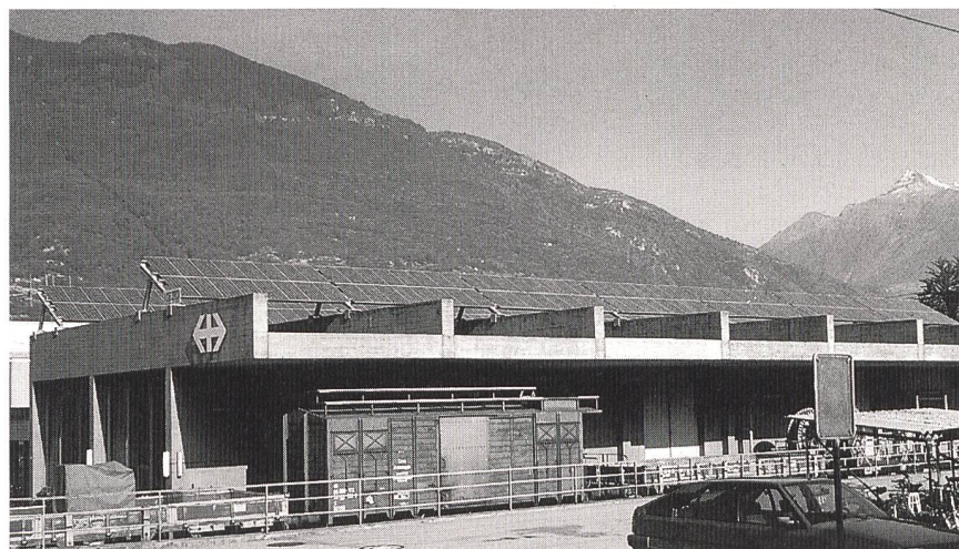
Bild 1 Photovoltaikanlage auf dem Dach des Fahrleitungsgebäudes.
