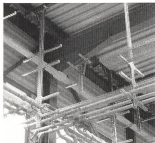
Das modulare Schienenmontage- und Befestigungssystem Multifix
