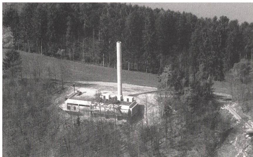
Das Deponiegas-Kraftwerk der BKW in Teuftal.
