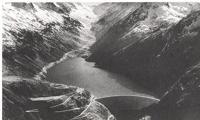
Der Stausee und die Staumauer Nalps liegen im Bereich über dem projektierten Gotthard-Basistunnel.
