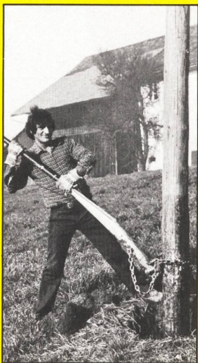
Nachimprägnierung von Holzmasten
