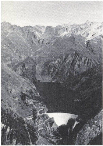
Die Staumauererhöhung von Luzzone tritt in die Realisierungsphase.
