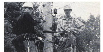
Besuchstag zum Netzelektriker-Einführungskurs für Freileitungsarbeiten in Lenzburg am 18. Mai 1994.
