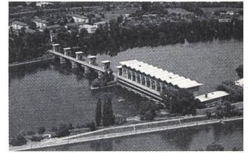
Das Kraftwerk Birsfelden (BL) soll für 100 Mio. Franken erneuert werden.
