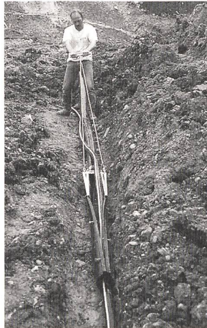
Längsverschlussrohr für Kabelschutz
