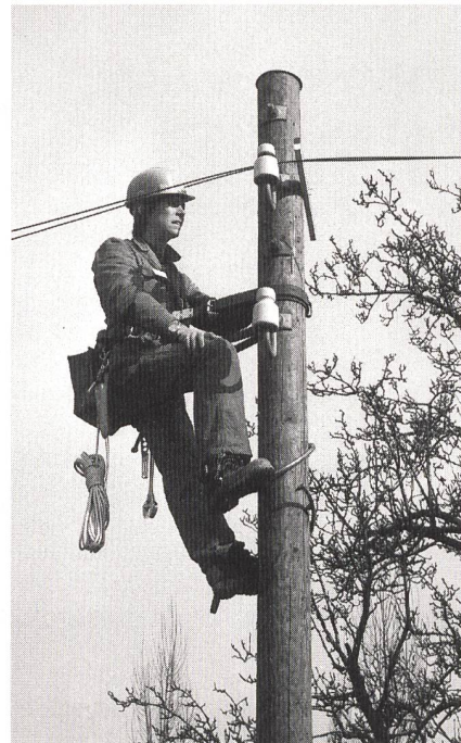
Netzelektriker bei der Arbeit
