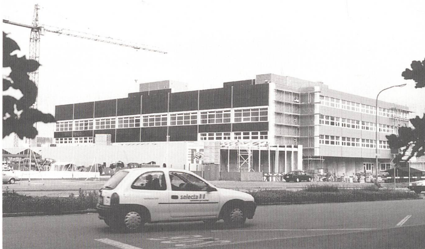
Die Solaranlage der Migros Winterthur verfügt über eine Leistung von 66,2 kW und erzeugt jährlich etwa 35 500 kWh Strom.
