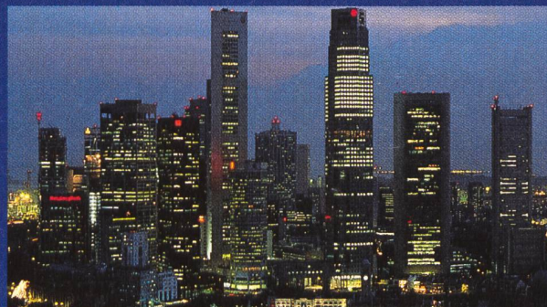
Singapur: Lieferung und Montage von Hochspannungskabeln
