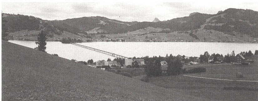
Der Sihlsee liefert dem Etzelwerk sein Wasser für die Stromproduktion.
