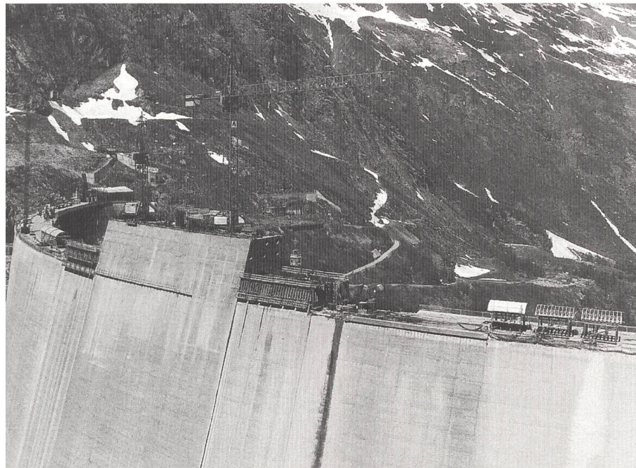
La surélévation du barrage de Mauvoisin entre 1989 et 1992. La décision d'augmenter la puissance de 550 MW - Mauvoisin II - a été ajournée.
