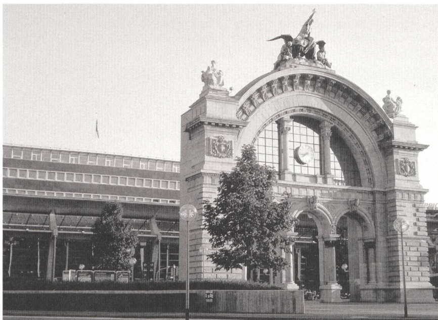
Innerhalb des Bahnhofs Luzern wird – auf dem Dach des Gewerbeschulzentrums – eine Photovoltaikanlage mit einer Spitzenleistung von 52,5 kW installiert (Foto: Tourist Information, Luzern).
