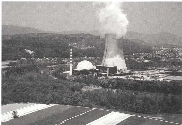
Das Kernkraftwerk Gösgen erzielte im letzten Betriebszyklus eine Rekordproduktion von 7,8 Mrd. kWh.
