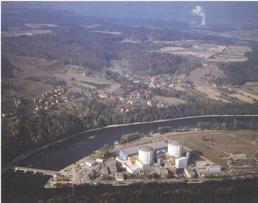
Bild 3 Wasser- und Kernkraftwerke mit hoher Bauqualität und guten Umweltwerten.
