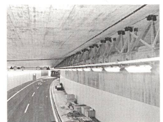
Polyester-Kabelbahn für Tunnels
