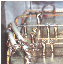
Sämtliche Steinhülsen sind mit der Armierung verschweisst.
