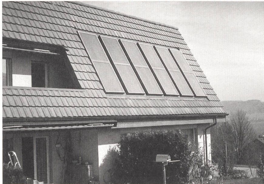
Bild 1 Luftkollektorfeld Zweifamilienhaus Ettenhausen/TG, Baujahr 1987.
