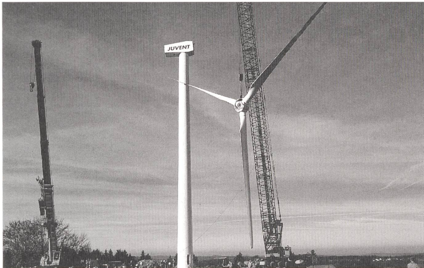
Die erste der drei Windturbinen wird mit Hilfe eines Spezialkrans auf dem Mont-Crosin montiert. Une des trois turbines éoliennes au Mont-Crosin a été montée à l'aide d'une grue automotrice spéciale.
