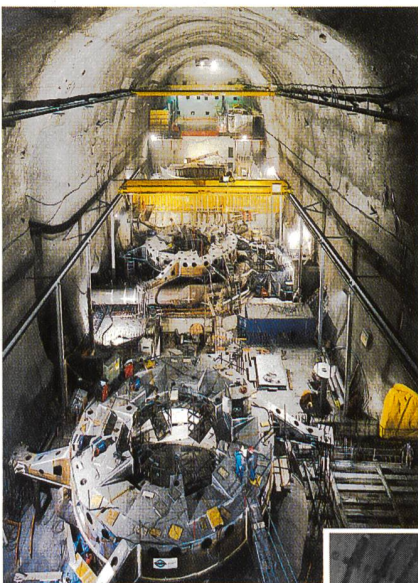
Ausbau der Kavernenzentrale des neuen Kraftwerks Biedron (VS).
