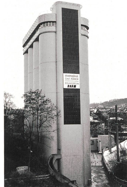
Die Solaranlage «Sirius» auf dem Getreidesilo der Stadtmühle CMZ Zürich.
