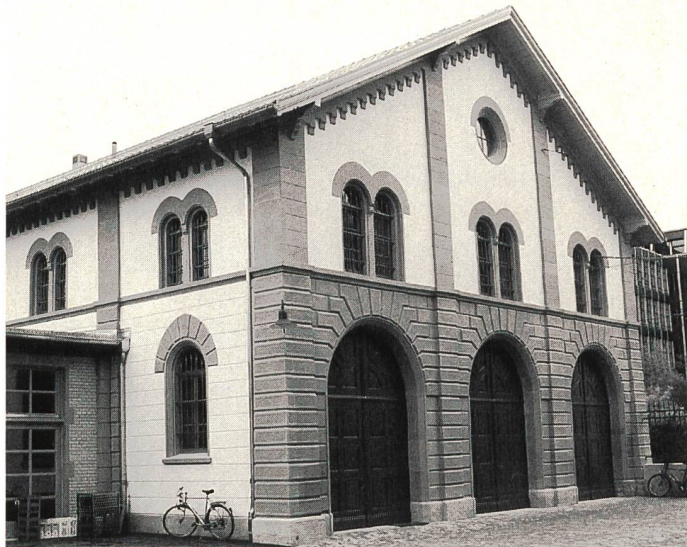
Das EWZ investiert in die Versorgungssicherheit: Im Juni 1996 begannen die Bauarbeiten zur Druckschächterneuerung Tinizong; im September wurde das 17. Unterwerk des EWZ, das Unterwerk Zeughaus in Zürich (Bild), eingeweiht.
