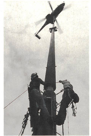
Der Freileitungsbau ist das eigentliche «pièce de résistance» der Arnold AG.
