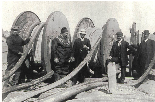
Bild 4 Verlegen von Unterwasserkabeln an der Themse (1863).
