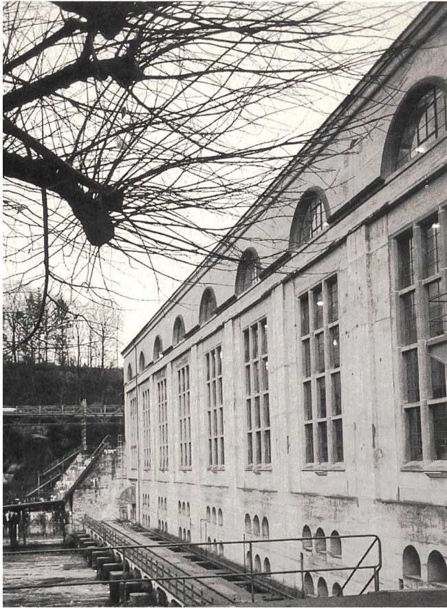
Das Wasserkraftwerk Mühleberg. Der Grundablass des Kraftwerkes wird für 8,2 Millionen Franken saniert.
