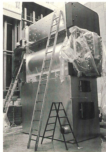
Der Holzschnitzelheizungskessel für die Nahwärmeversorgung Krummeneich Pratteln mit einem Gesamtgewicht von etwa 17 Tonnen und einer Leistung von 1200 kW wird in Pratteln installiert.
