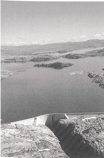
Forrevassdammen, Norwegens grösster Betondamm, 95 m hoch, 1300 m breit: elegante Einbettung in die Landschaft mit Gewichtsstauwand und zusätzlicher Bogenstütze (Bild Statkraft).
