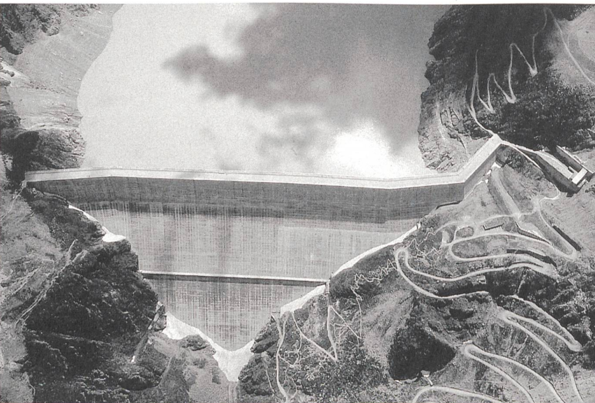
Höchste Gewichtstaumauer der Welt: Grande Dixence (VS, 6 Mio. m 3 Beton): «saubere Lösung» mit leichten Asymmetrien (Photo Germond).
