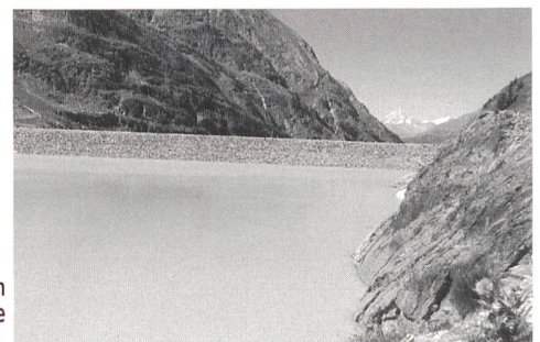
Rückhalt von 115 m 3 /s im Stausee Mattmark.
