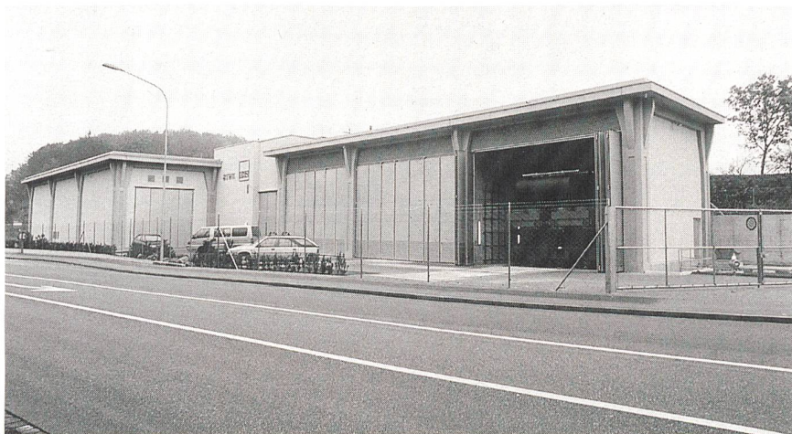
Wegen der engen Platzverhältnisse zieht sich das Unterwerk Balsberg in die Länge. Rechts die zwei Transformatoreinheiten 110/16 kV, deren Abwärme für die Gebäudeheizung abgezeigt wird.
