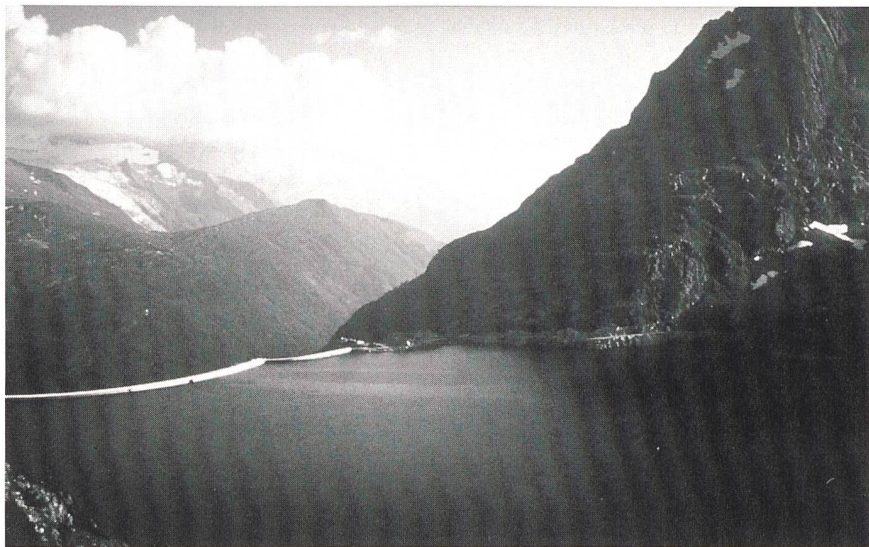
Der Stausee Emosson: 1996/97 ist die Stromproduktion um 5,1% auf 624 Mio. kWh gesunken.
