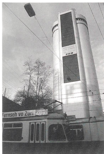
Bild 1 Solarstromanlage «Sirius», Zürich.
