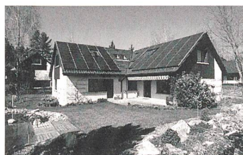
Bild 4 Photovoltaikanlage auf Einfamilienhaus, Nürensdorf (Foto K. Heimberg).
