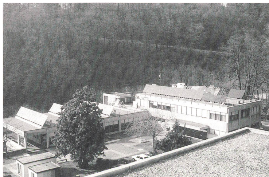
Bild 1 10-kW p -m-Si-Anlage (1982) und 4-kW-a-Si-Anlage (1988).
