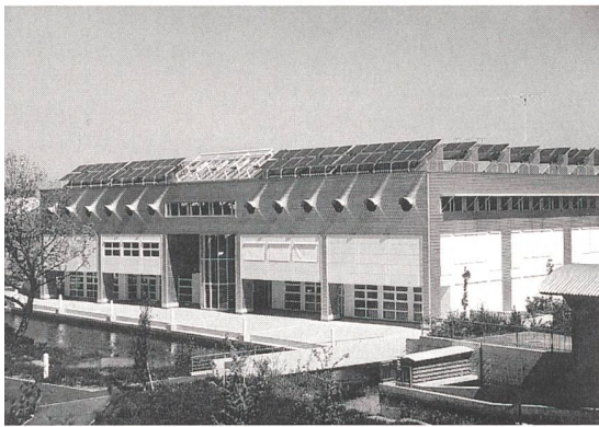
Auf dem Neubau der Abteilung Elektrotechnik befindet sich die 60-kW p -Photovoltaik-Testanlage der Ingenieurschule Burgdorf.
