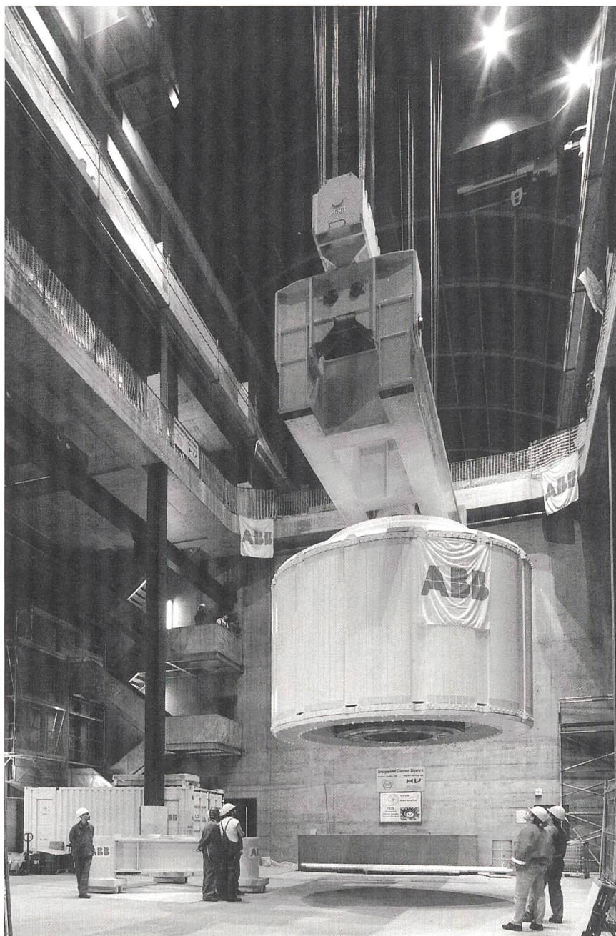
Cleuson-Dixence: Le premier rotor a été mis en place le 18 août 1997 dans le groupe 3.
