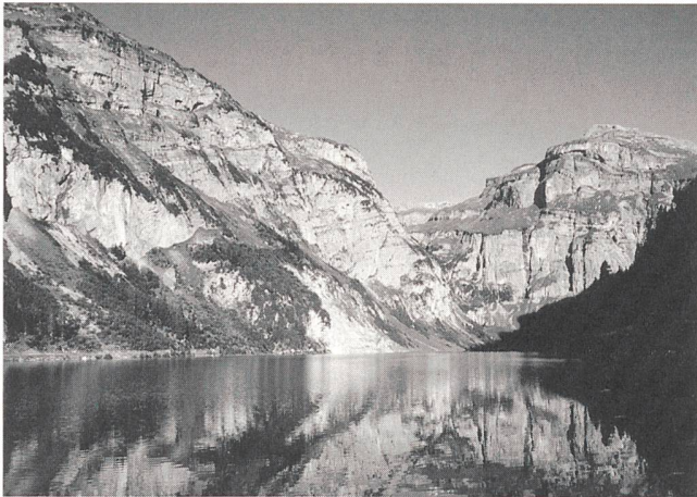
Gebirgskantone befürworten Vorrangstellung für die Wasserkraft (im Bild Stausee Panix /GR).
