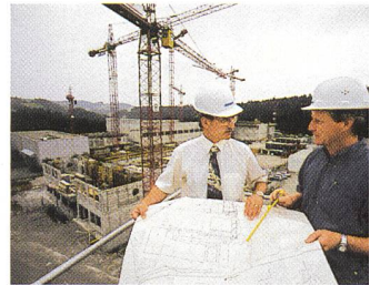
▲ Baustelle des ZWILAG: Errichtung und Betrieb von Entsorgungsanlagen für radioaktive Abfälle in Würenlingen (AG). ▼
