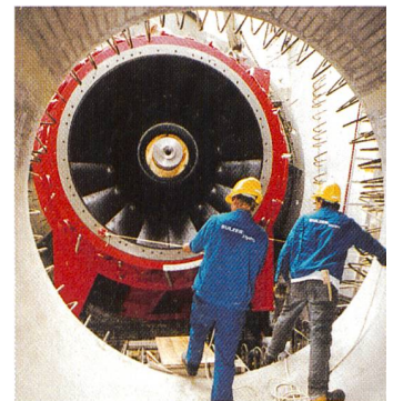
Einbau der Rohrturbine für das Reusskraftwerk Mühlenplatz in Luzern.
