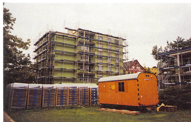
«Energie 2000»: energetische Sanierung von Gebäuden.
