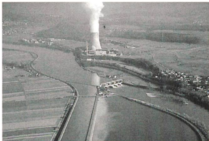
Gemäss HSK ist ein sicherer Anlagebetrieb des Kernkraftwerks Leibstadt auch bei einer Leistungserhöhung gewährleistet.
