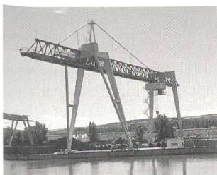
Verladebrücke im Hafen Krems.
