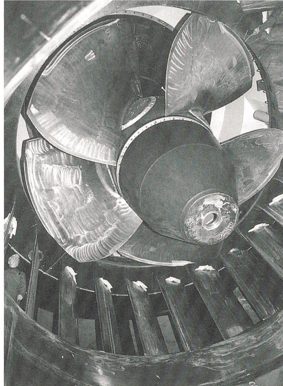
Dank dem Ersatz der imposanten Turbinenlaufräder und zahlreicher weiterer Sanierungsmassnahmen wird das Flusskraftwerk Wildegg-Brugg künftig mit einer installierten Leistung von 50 MW jährlich etwa 300 Mio. kWh Strom erzeugen können.
