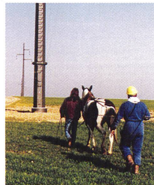
Bodenschonender Leitungsbau mit Jessy
