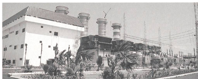
Weiterhin stark dominierende fossile Energieträger in den Schwellen- und Entwicklungsländern: GUD-Kraftwerk in Malaysia (Bild Siemens).
