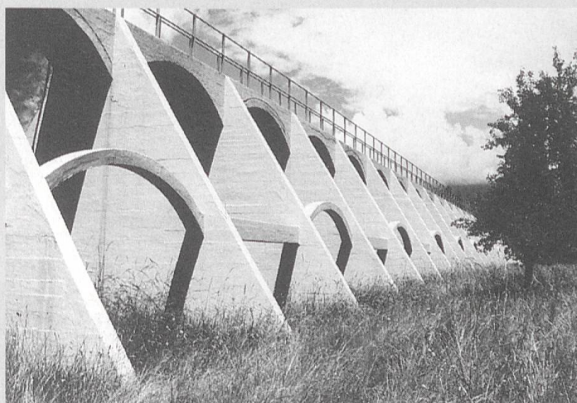
Staumauern: Ein schönes Beispiel ist die vor rund 75 Jahren erbaute, mit ihrer Leichtigkeit fast verspielt wirkende Mehrfach-Bogenstaumauer des Ausgleichsbeckens der SBB-Kraftwerke Châtelard-Barberine-Verneyaz bei Les Marécottes (VS). (Foto: Emmanuel Rey)
