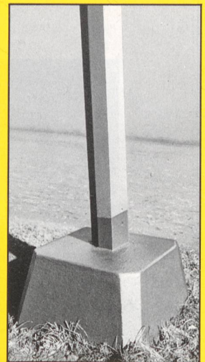
Betonschutz an Mastsockeln
