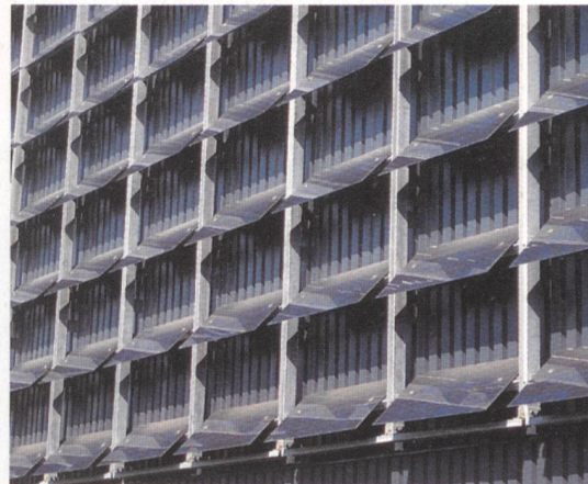
Titelbild: In Fassade integrierte Photovoltaikanlage (Foto H.R. Bramaz).
